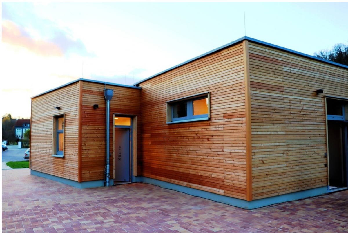
Caravan Stellplatz mit Servicegebäude Louiseneck | ©Felix Ihle
