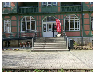
Weg außen vor Eingang
