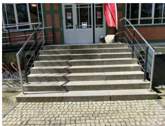
Treppe am Eingang
